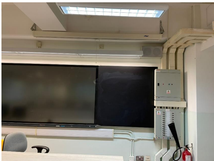
設計及新造木櫃修飾遮蔽電箱及外露喉管
